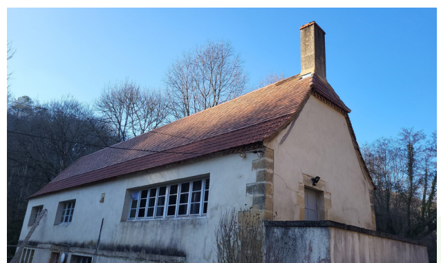
Moulin de Lavaur
